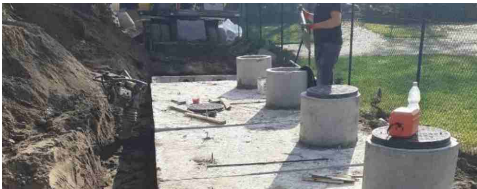
Budowa podziemnego zbiornika retencyjnego przy obiekcie Apartamenty Frydek w Wąbrzeźnie (fot. M. Politowski)
