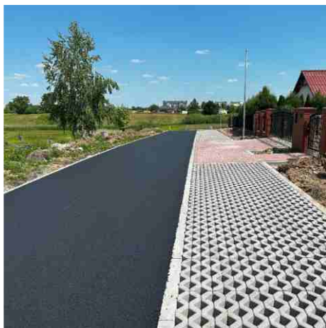
Ulica Poziomkowa w Wąbrzeźnie w trakcie budowy (fot. Tomasz Zygnarowski)
